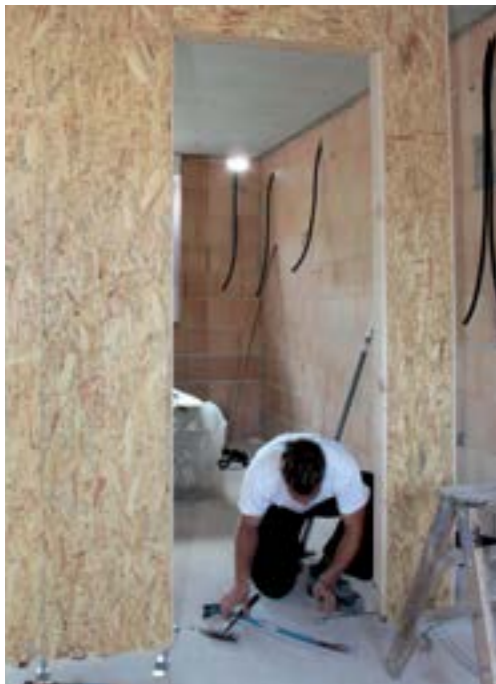
Montage des fortlaufenden 2. Elementstücks
