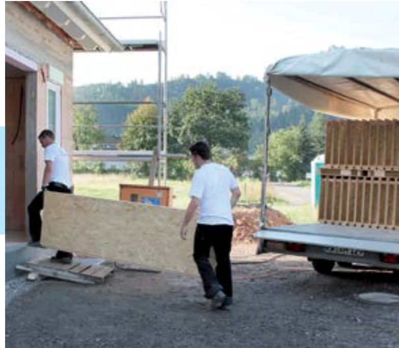
Platzsparender Transport der Wandelemente, stehend auf LKW oder Hänger, Zulieferung ins Gebäude mit 2 Mann.
