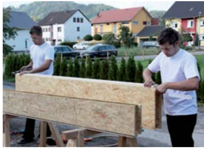
Tragprofil in das aufgeschnittene Element einsetzen
