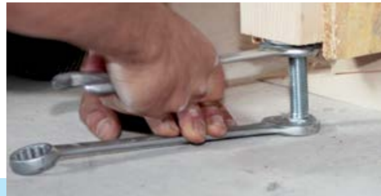
Tragbolzen durch kraftschlüssige Verschraubung zur Decke andrücken
