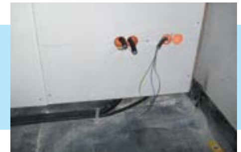
Beidseitiger Elektroeinbau sofort nach Gipskartonplatten-Bepunktung
