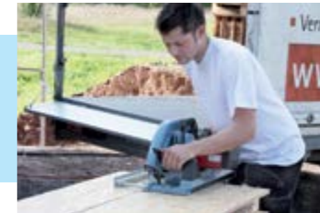
Montage der Wandelemente im 5 Min-Takt
