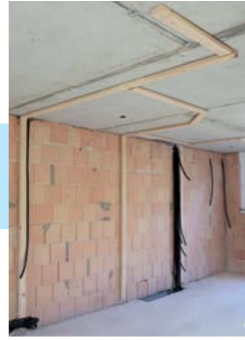
Wandposition einmessen und die Decken- und Tragprofile (hier als Wandanschlüsse) montieren
