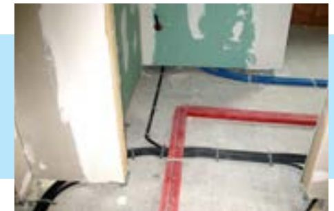
ungehinderte Leitungsführungen am Boden, innerhalb einer Wohnung
