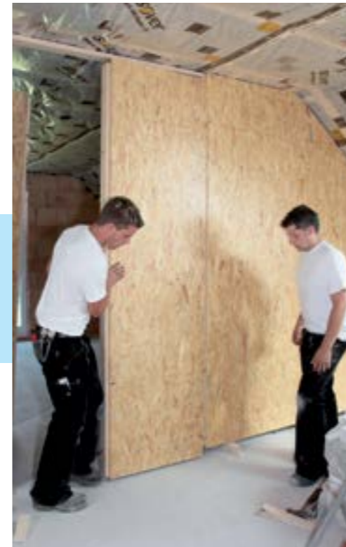
Element in Position aufstellen und seitlich einpassen
