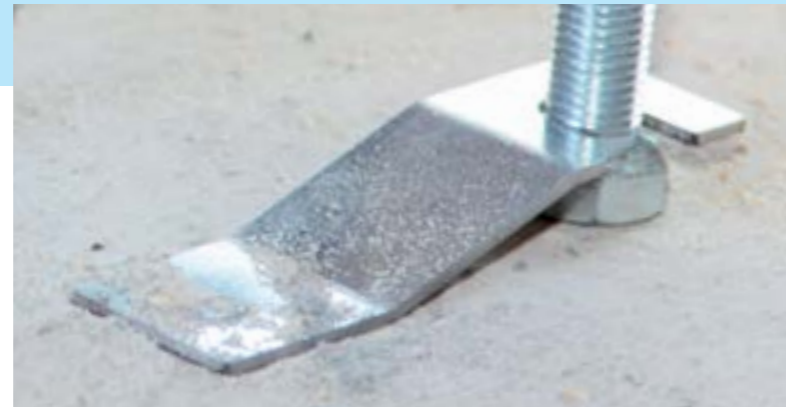
Bodenhalter in Tragbolzen einhängen und andübeln.
