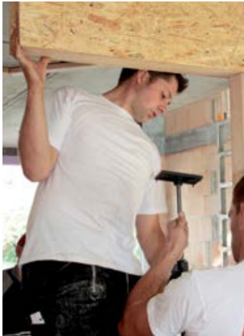
einfacher Türsturzeinbau durch Decken- und Türleibungsführung
